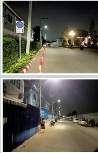
ติดตั้งไฟฟ้าส่องสว่าง ซอยประชาอุทิศ 5
